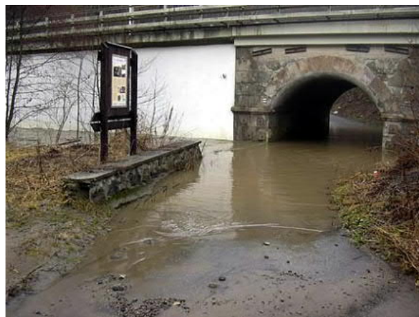
Obr. 2.2 Povodeň březen 2006 – Svitava pod železniční tratí na Brno
