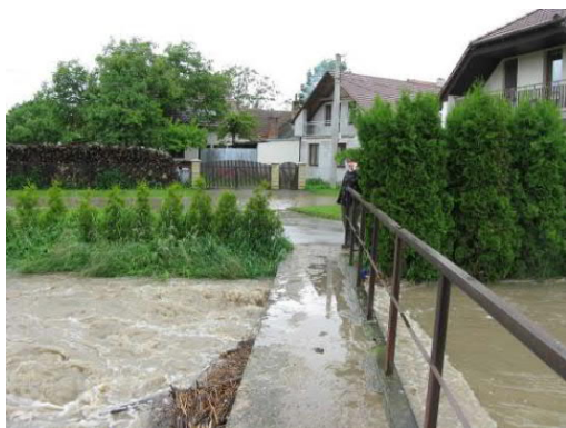
Obr. 2.3 Lávka v km 46,146 , voda při kulminaci přetékala, na PB obtéká voda z Litenčického p.
