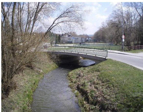
Obr. 2.9 Most přes Vápovku
