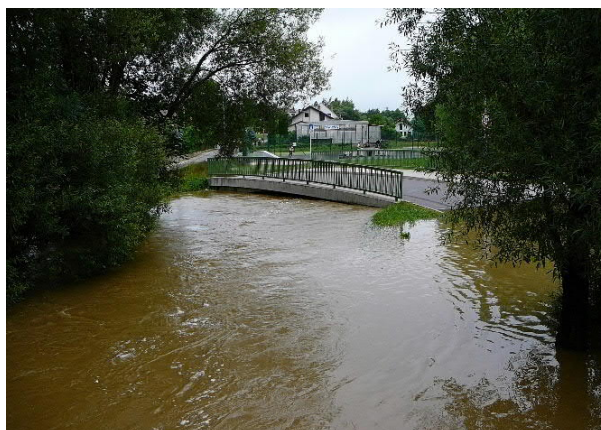
Obr. 2.10 Most přes Vápovku
