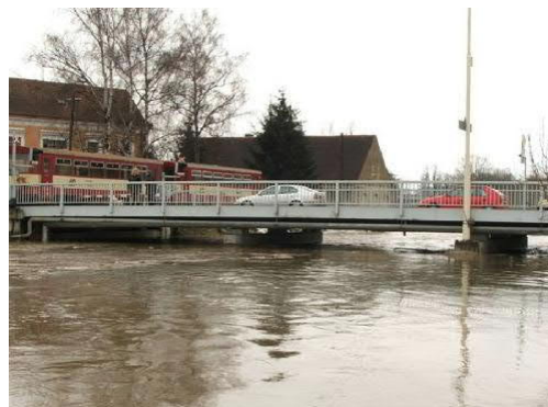
Obr. 2.2 Moravská Dyje v Dačicích, 29.3.2006
