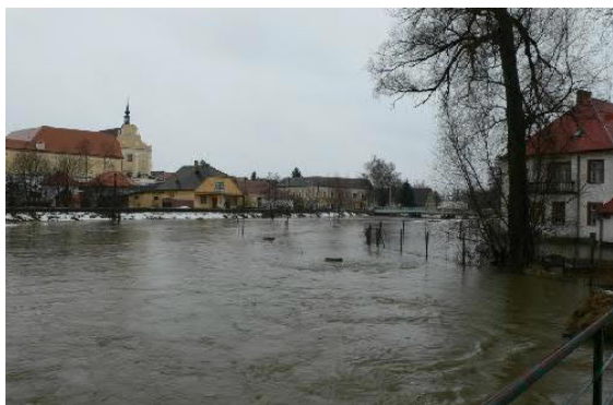
Obr. 2.1 Moravská Dyje v Dačicích, 29.3.2006
