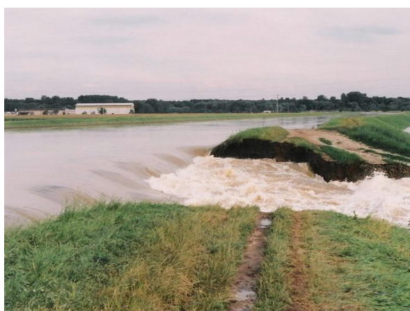
Obr. 2.4 Povodeň 1997 – protržená hráz v Lužici
