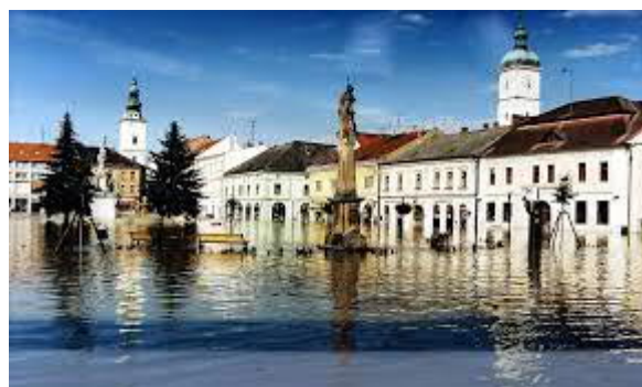
Obr. 2.2 Povodeň 1997 – Uherské Hradiště
