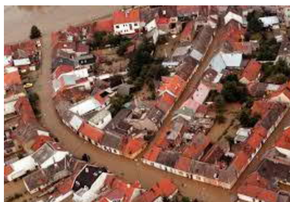
Obr. 2.4 Povodeň 1997 – Uherské Hradiště
