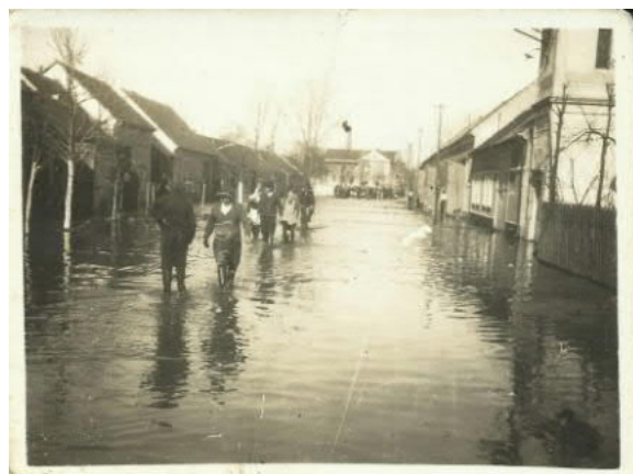
Obr. 2.14 Povodně 1940 Ostrožská Nová Ves
