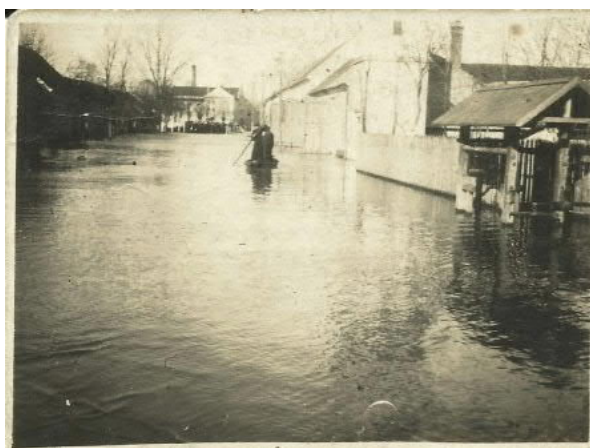
Obr. 2.15 Povodně 1940 Ostrožská Nová Ves
