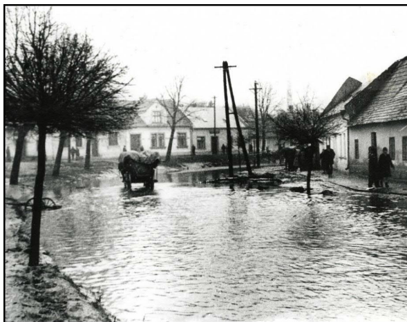
Obr. 2.1 Povodeň v r. 1931 ve Vyškově na Hané
