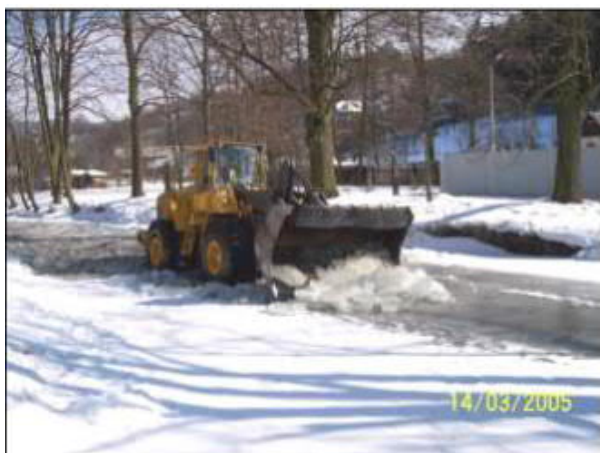
Obr. 2.9 Povodeň 14. března 2005 – rozbíjení ledových bariér za pomoci techniky [6]
