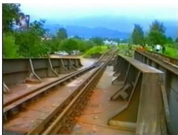
Obr. 2.6 Povodeň 1997 – železniční trať
