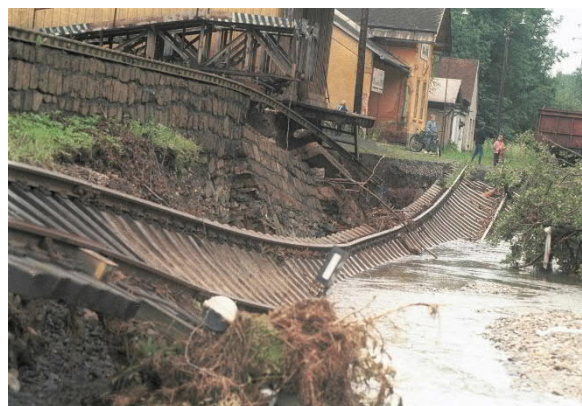
Obr. 2.2 Povodeň 1997 – nádraží Loučná n. Desnou
