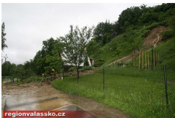
Obr. 2.3 Povodeň 2010 – Brumov-Bylnice, sesuv
